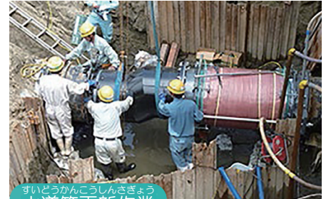
すいどうかんこうしんさぎょう 水道管更新作業
