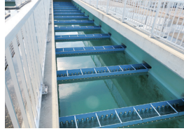
やくひんちんでんち 薬品沈殿池
