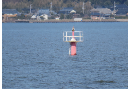
しゅすいとう 取水塔
